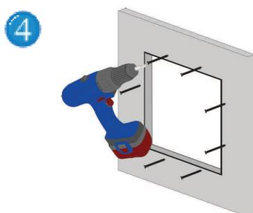
Premete il telaio esterno contro la parete dal retro e fissatelo alla parete di gesso rivestito con viti autofilettanti ad una distanza massima tra loro di 17 cm. Il telaio non sarà a filo lastra, ma sporgente, in modo che successivamente potrà essere intonacato.
